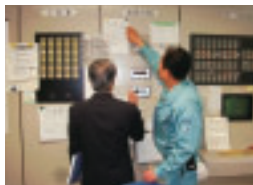
施設制御室(所沢店)
