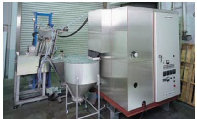
大阪ガスの本社ビルに導入された生ごみ用真空乾燥機。ガスエンジンの燃焼によって電気をつくるコ・ジェネレーションシステムの排熱水を、乾燥の熱源として利用するシステムです。
