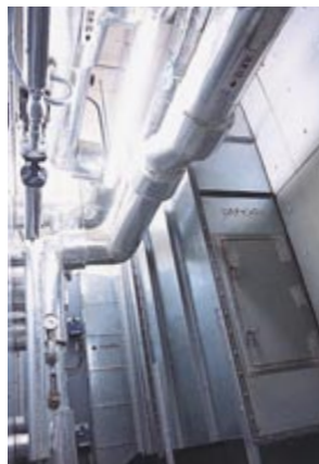
外気20度を目安に、コントロールセンターのコンピュータにより稼働を開始します。
